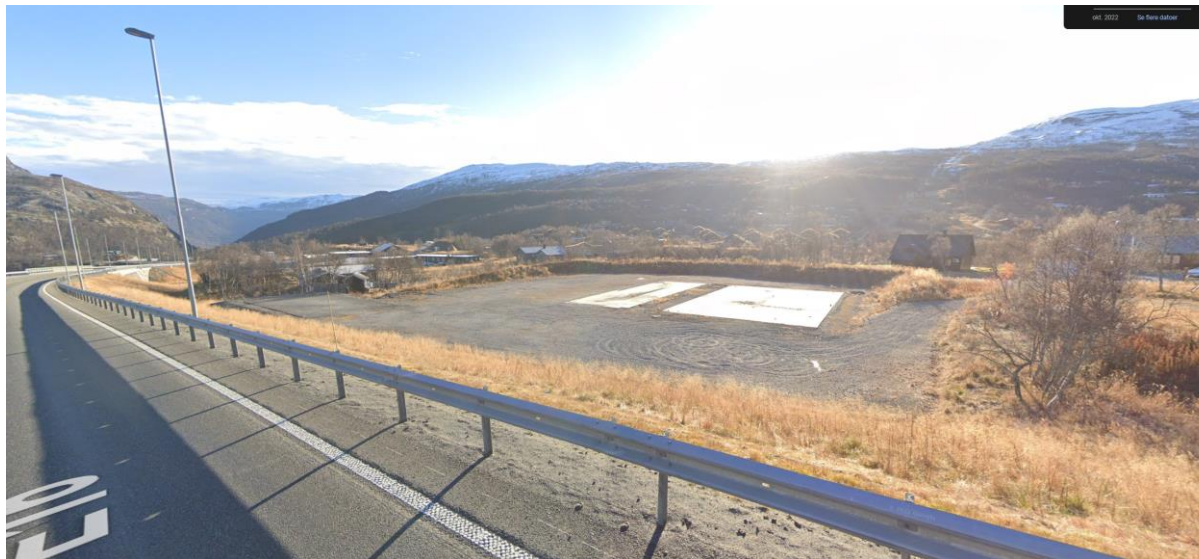
Figur 9: Bildet viser parkeringsplass langs europavegen (bilde: google street view).
