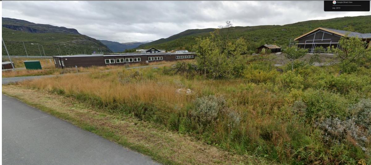
Figur 8: Bildet viser brakkebygget retning øst (bilde: google street view).
